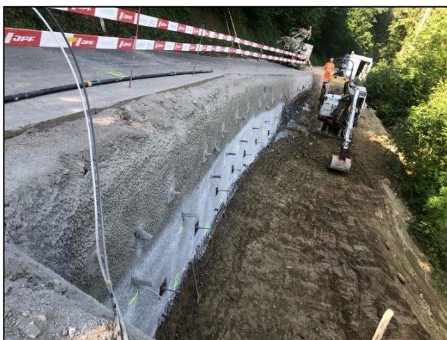
Travaux spéciaux : paroi clouée et paroi berlinoise
