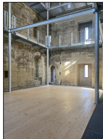
Le plancher du rez-de-chaussée est tout neuf !
