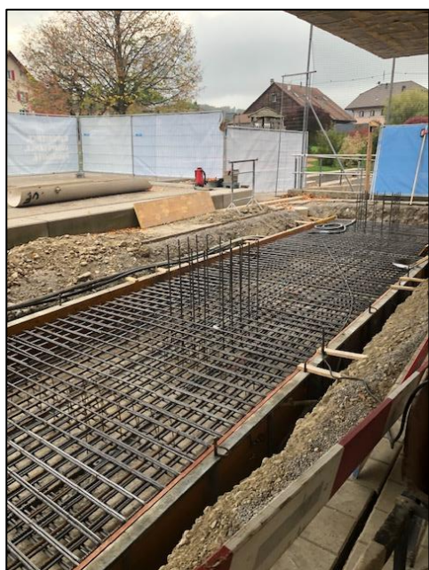
Ferrailage du radier de l'entrée
