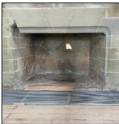
Belle conservation du manteau de cheminée au rez-de-chaussée
