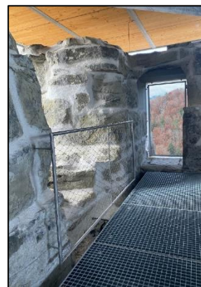
Sécurisation au 3 e étage
