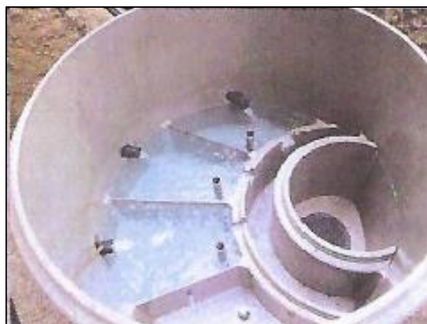
Captage conforme aux exigences SSIGE (Pas d'accès direct sur le plan d'eau, mise en décharge des différentes sources)
