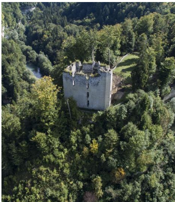
Ce qu'il restait du château dans son écrin de verdure avant les travaux de préservation.
